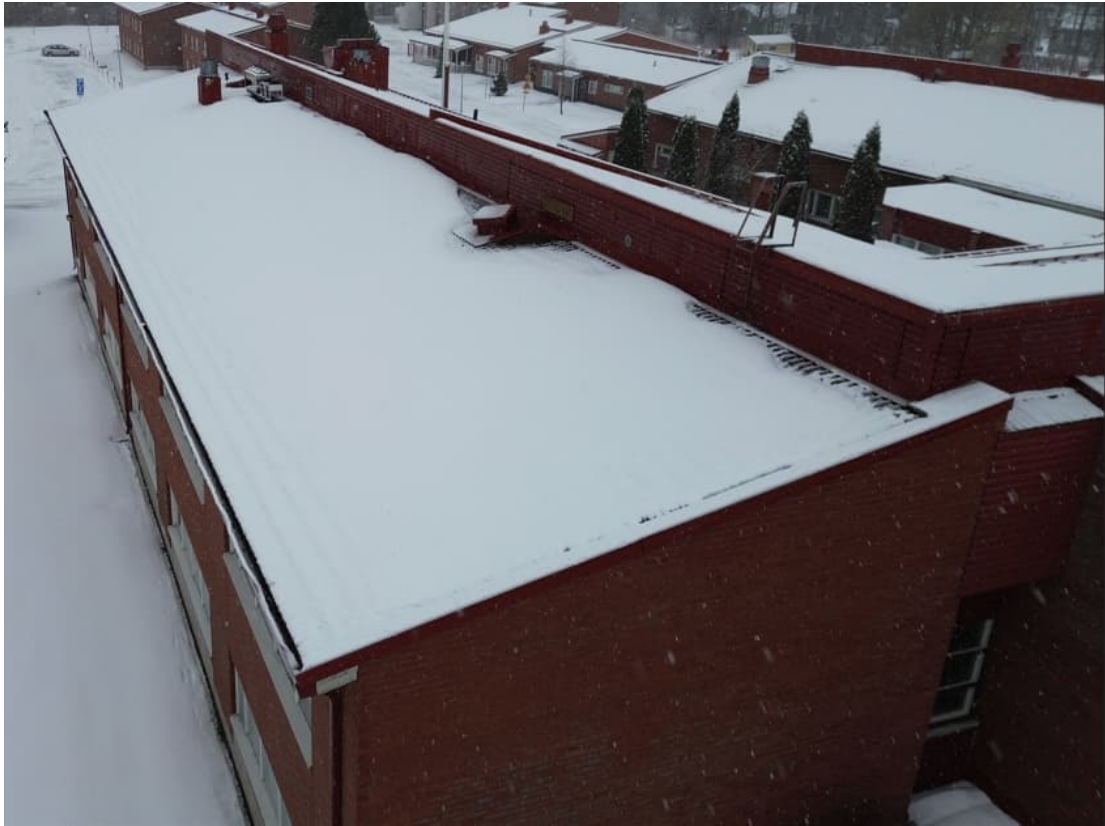
Kuva 8: Yleiskuva moduulin A-B/2-8 korjattava vesikatto
