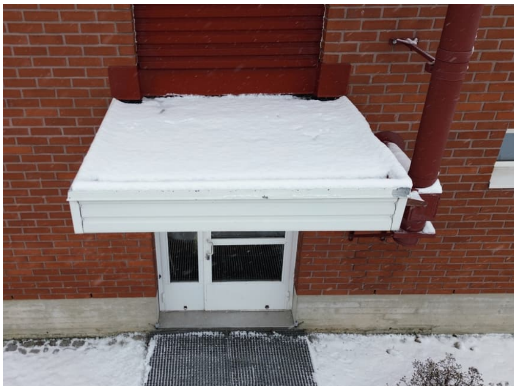
Kuva 13: Yleiskuva moduulin D/6-7 korjattava vesikatto
