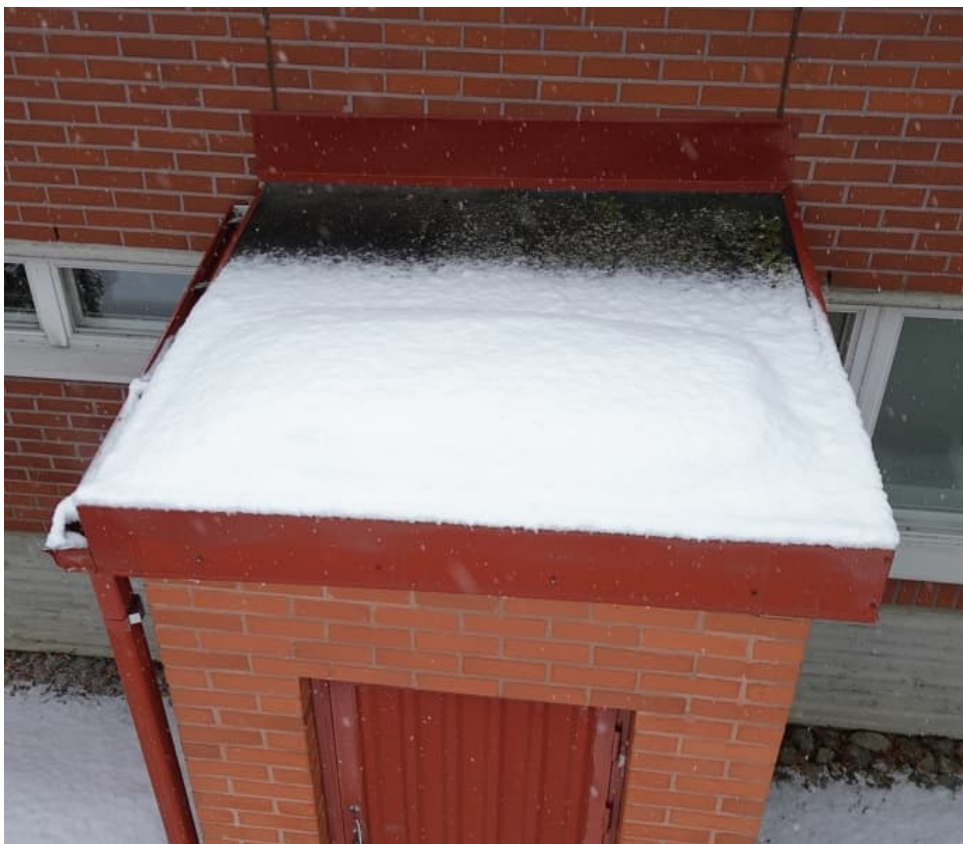
Kuva 14: Yleiskuva moduulin G/7 korjattava vesikatto
