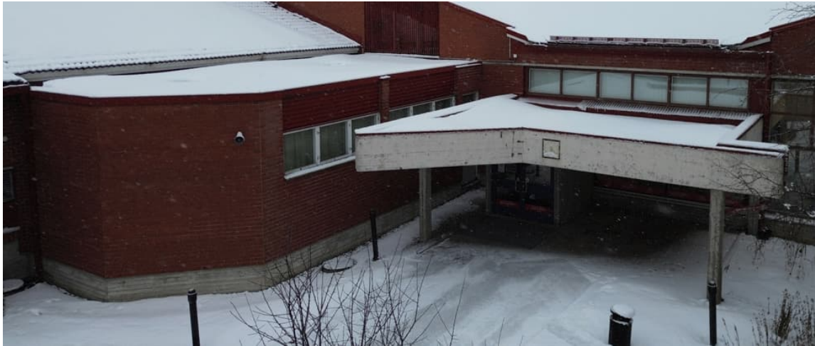
Kuva 10: Yleiskuva moduulin E-G/4-6 korjattavat vesikatot
