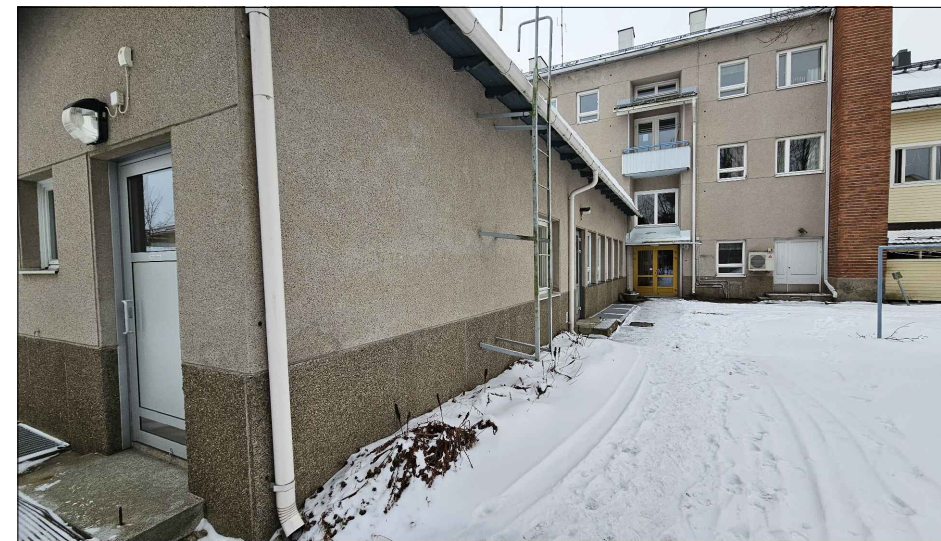
Oleva tilanne helmikuu 2025: Julkisivu koilliseen ja luoteeseen
