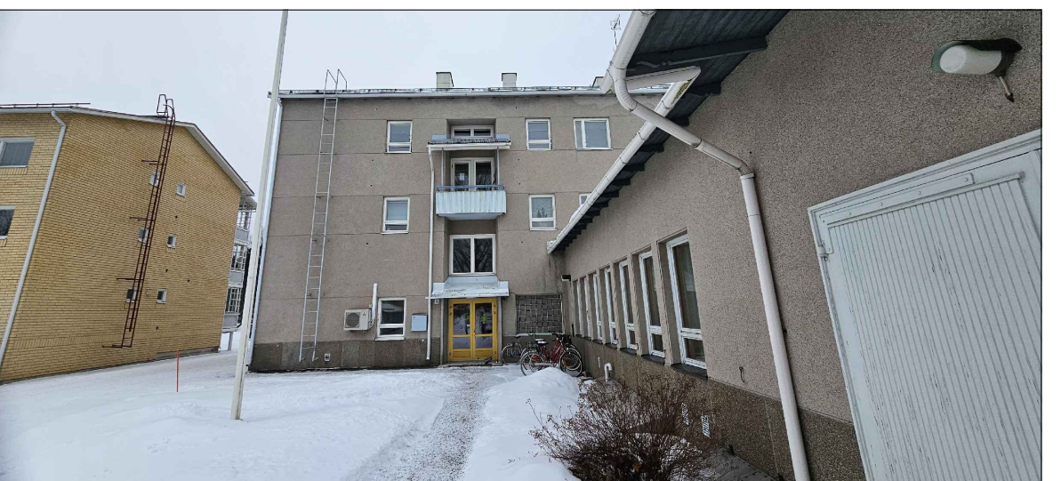
Oleva tilanne helmikuu 2025: Julkisivu koilliseen ja kaakkoon
